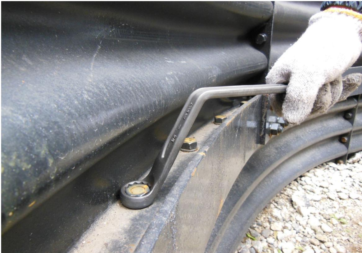
・補強リングのボルト締結に
