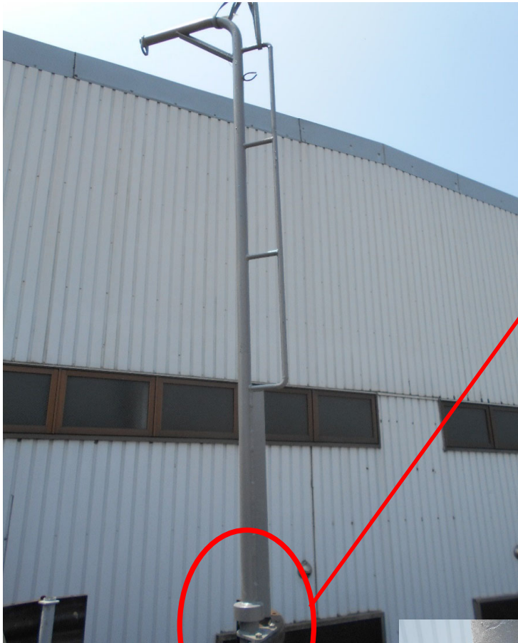
↑受けポール（1000mm）をライナーにボルト固定
